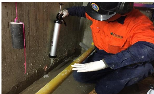
Injecting PU
